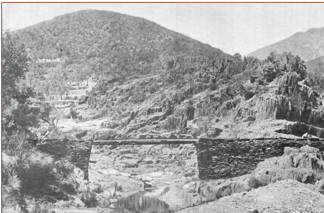
Un acueducto en la conducción de aguas hecha por D. Julián Mancebo para el riego de la vega de Las Mestas.
