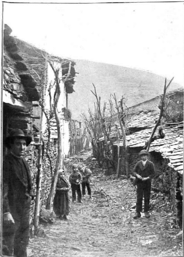
Calle principal de Mestas.
